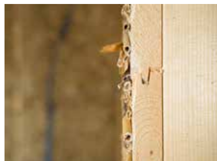
Innenwand: Auf der Schilfrohrmatte haftet der Putz gut.
