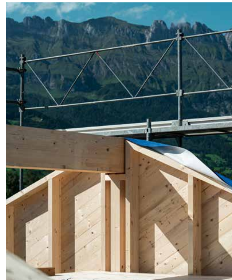
Mit der Diagonalschalung ist das Gebäude versteift und abgeschlossen.
