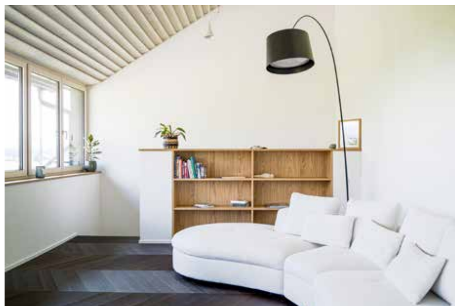
Die offene Stulpschalung sorgt für eine angenehme Akustik.
