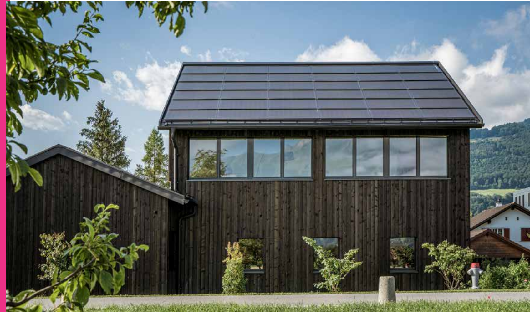
Das Einfamilienhaus in Grabs (SG) kommt ohne Lüftungstechnik aus: Die Aussenhülle aus Holz und Stroh reguliert Wärme und Feuchtigkeit perfekt.
