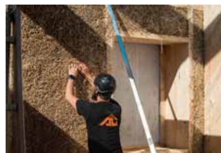
Die Aussenwand wird innen mit Kalkputz geschlossen.
