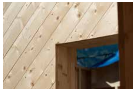
Auf Diagonalschalung folgt hinterlüftete Holzfassade.
