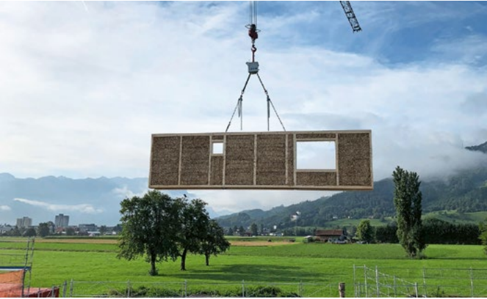
Für den Einbau des mit Stroh gedämmten Hauses braucht es trockenes Wetter.
