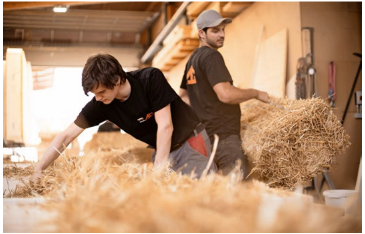
In der Halle werden die Wände witterungsunabhängig vorgefertigt.
