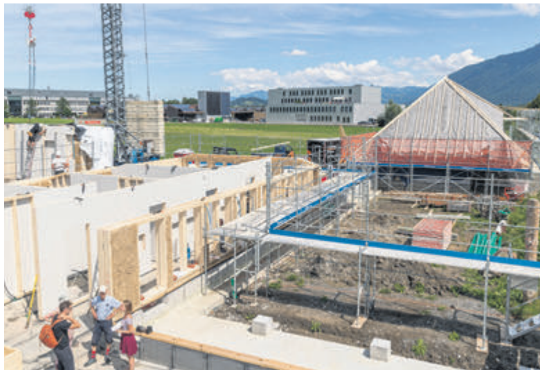
Die Wände aus Stroh, Lehm und Holz stehen. Bald geht es an den Innenausbau der Räumlichkeiten.
